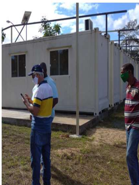
Dia 17/06/2020 - Equipe da Soma em Pádua realizando o levantamento dos serviços de eletricidade para os contêineres.
