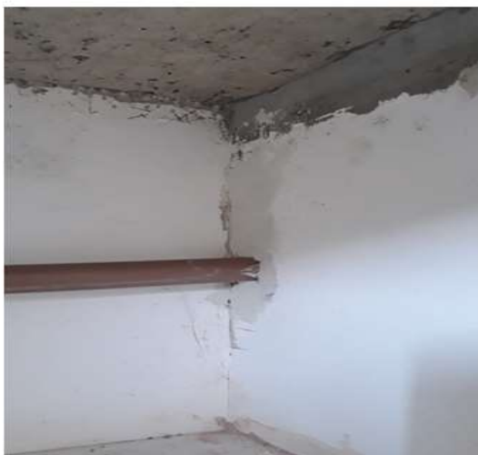
Dia 02/06/2020 - Arrematada, com cimento branco, as instalações feitas para a máquina de gelo no Instituto Biomédico do Campus Valonguinho.
