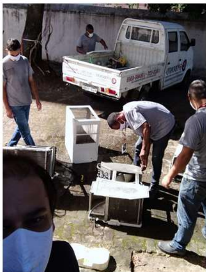
Dia 22/06/2020 - Manutenção corretiva de aparelhos de Ar-condicionado na Faculdade de Farmácia.
