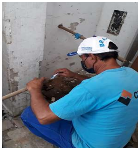
Dia 02/06/2020 - - Instalação de ponto de água externo ao galpão do novo Almoxarifado da Soma no Campus Gragoatã para correta higienização do pessoal ao chegar ao local de trabalho. Medida de preparo para o futuro retorno integral às atividades.
