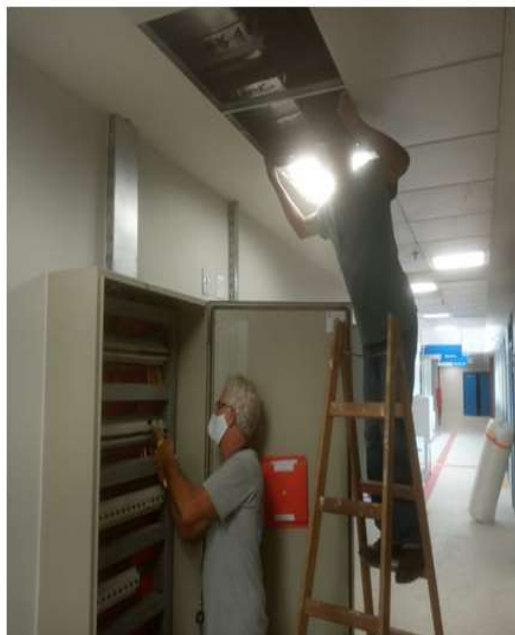
Dia 26/06/2020 - Serviço de instalação elétrica de centrífuga do Instituto de Biologia.
