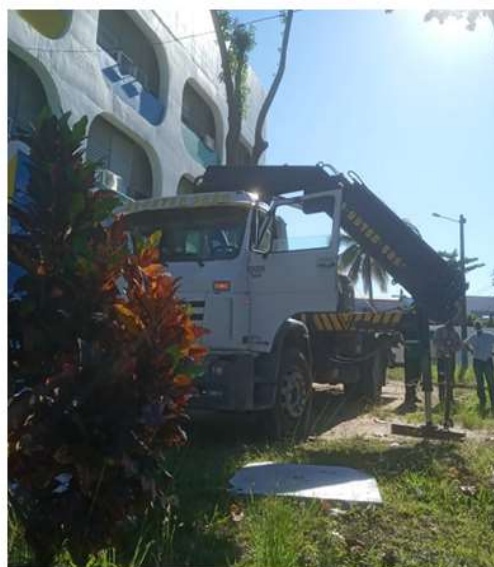
Dia 18/06/2020 - Substituição do transformador (Trafo) do Colune.
