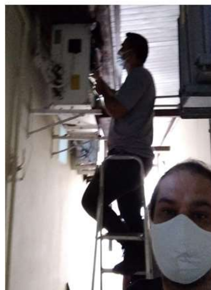
Dia 22/06/2020 - Manutenção corretiva de aparelhos de Ar-condicionado no Centro Médico da Reitoria.
