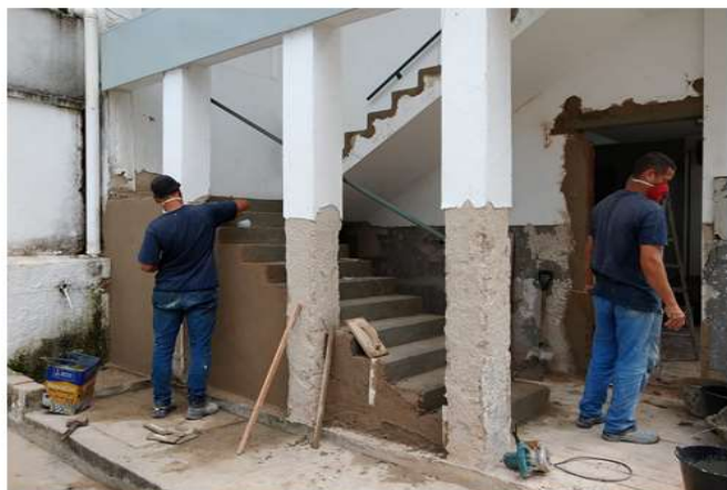
Dia 05/06/2020 - Andamento da obra da Procuradoria da Reitoria.
