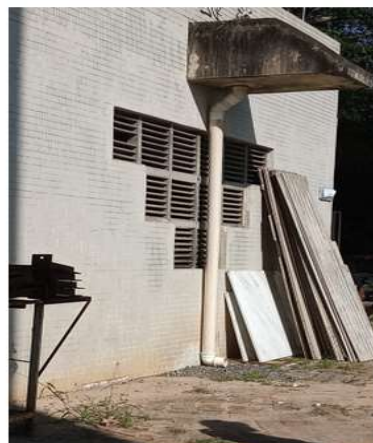
Dia 08/06/2020 - Instalação de tubo para escoamento de águas pluviais próximo ao novo Almojarifado da Soma no Campus Gragoatá.
