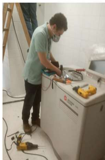
Dia 26/06/2020 - Serviço de instalação elétrica de centrífuga do Instituto de Biologia.
