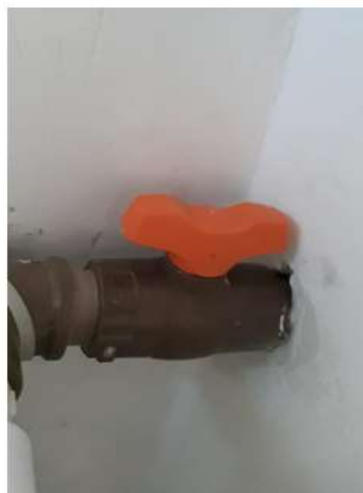
Dia 02/06/2020 - Arrematada, com cimento branco, as instalações feitas para a máquina de gelo no Instituto Biomédico do Campus Valonguinho.
