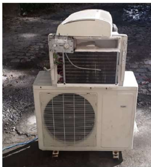
Dia 17/06/2020 - Manutenção preventiva e corretiva de aparelhos de Ar-condicionado na Biblioteca Central do Gragoatá.
