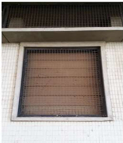
Dia 02/06/2020 - As grades que estavam para fora das esquadrias foram encaixadas no Bloco B do Campus Gragoatã.
