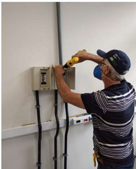
15/06/2020 - Serviço referente à instalação do microscópio confocal no Bloco M - Instituto de Biologia - no Campus Gragoatá.
