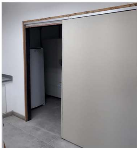
Dia 02/06/2020 - Instalação de porta de correr do 7º andar do Bloco E do Campus Valonguinho.
