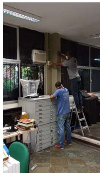
Dia 17/06/2020 - Manutenção preventiva e corretiva de aparelhos de Ar-condicionado na Biblioteca Central do Gragoatá.
