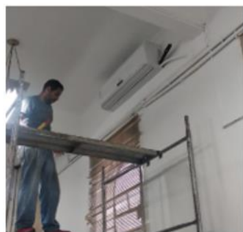
Instalação de ar-condicionado na Faculdade de Direito I
