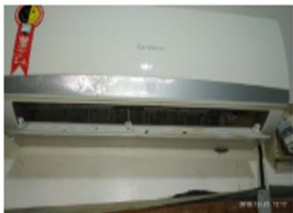
Limpeza dos filtros de ar e da turbina do ar-condicionado do NAL
