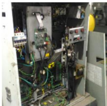
Instalação do módulo IGBT para retomada de funcionamento do elevador do bloco A, Campus Gragoatá
