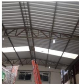
Substituição da iluminação da garagem do setor de transporte
