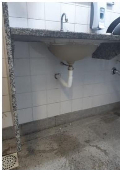
Dia 14/02/2020 - Manutenção feita em banheiro no Mequinho.
