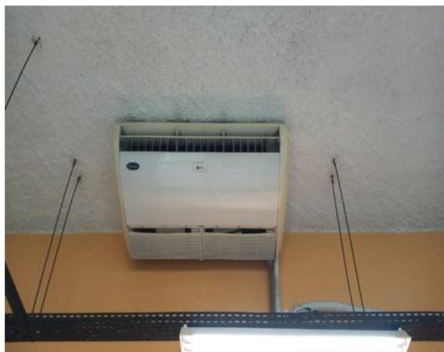
Dia 14/02/2020 - Recuperação de ar condicionado na Biblioteca Central do Valonguinho.
