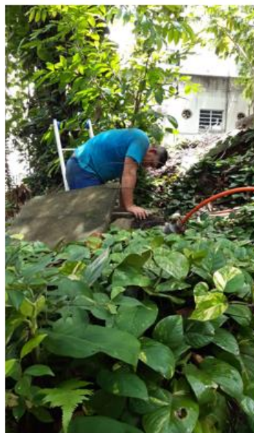
Dia 03/02/2020 - Instalação de boia em cisterna de cantina do campus Valonguinho.
