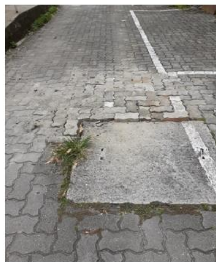
Reparação do calçamento do estacionamento do prédio velho do Instituto Biomédico no campus Valanguinho.
