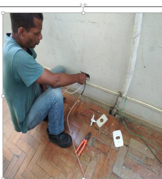
Dia 14/02/2020 - Manutenção nas instalações do Prédio principal da Direito I.
