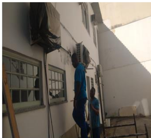
Dia 19/02/2020 - Substituição dos suportes dos Splits dos fundos da Reitoria.
