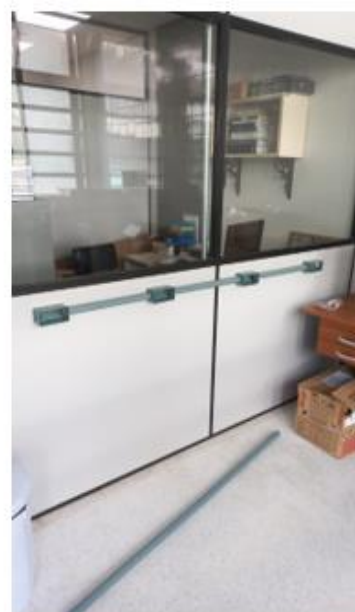
Dia 20/04/2022 – Instalação de novo circuito de tomadas no Laboratório nº 300 do Bloco M (Instituto de Biologia) no Campus Gragoatá.
