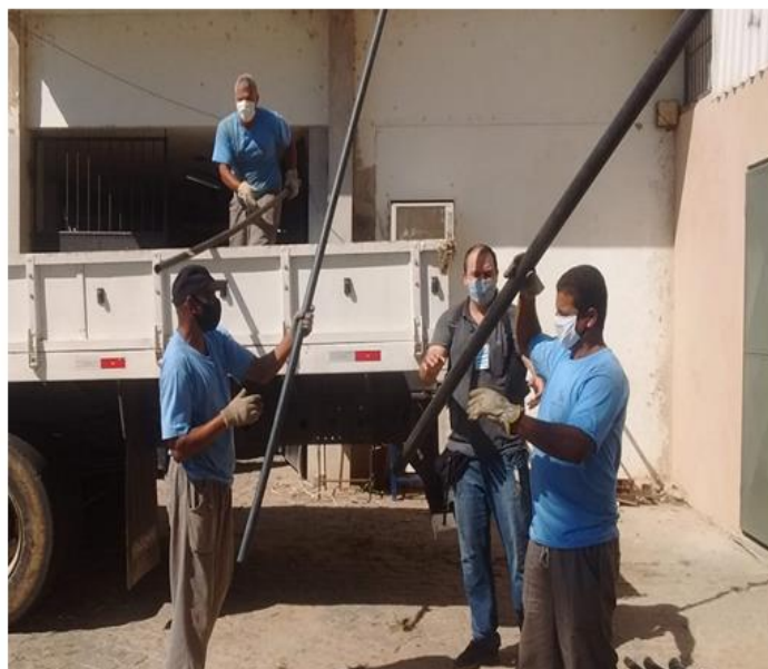
Dia 20/08/2020 - Serviços sendo realizados pela equipe da empresa Rio Minas no almoxarifado da SOMA no Campus Gragoatá.
