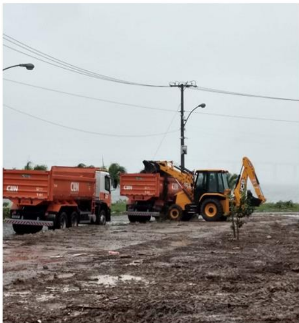
Dia 22/08/2020 - Parceria com a Prefeitura do Município de Niterói para a limpeza antes do lançamento do início das obras do IACS no Campus Gragoatá.
