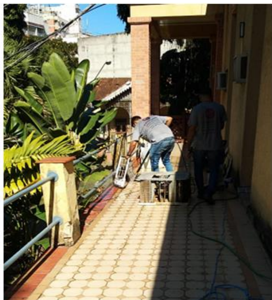
Dia 07/08/2020 - Manutenção preventiva e corretiva de aparelhos de Ar-condicionado na Escola de Arquitetura e Urbanismo de Arquitetura no Campus Praia Vermelha.
