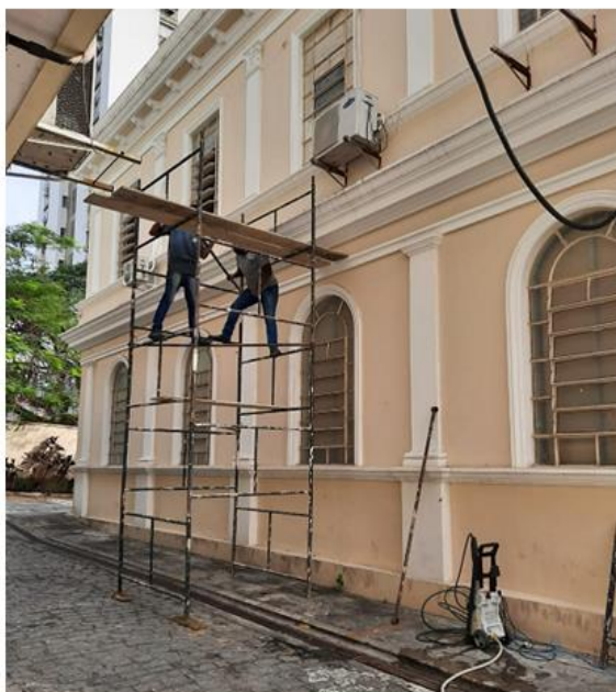
Dia 18/08/2020 - Manutenção de aparelhos de Ar-condicionado na Faculdade de Direito I.
