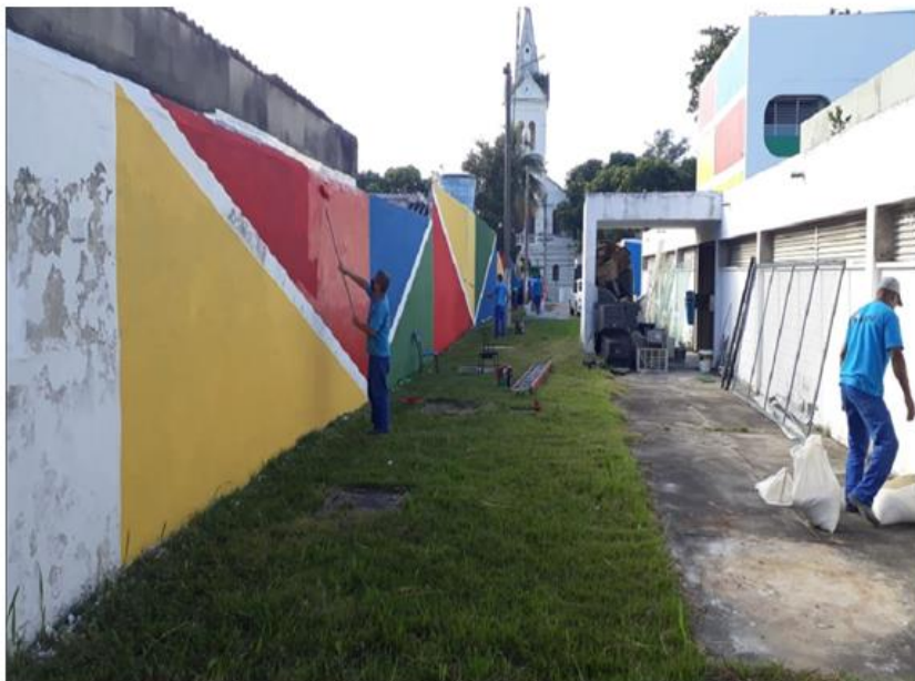
Dia 13/08/2020 - Recuperação e pintura do muro do Coluni.
