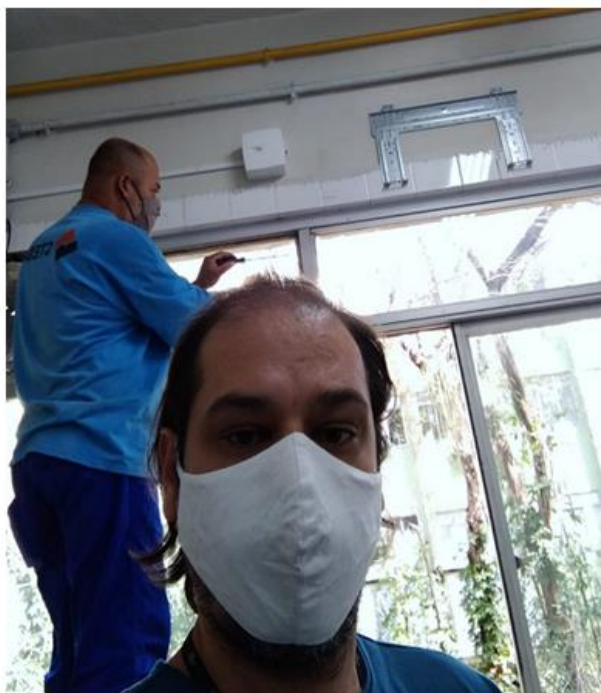
Dia 25/08/2020 - Remanejamento de aparelho de Ar-condicionado na Faculdade de Nutrição no Campus Valonguinho.
