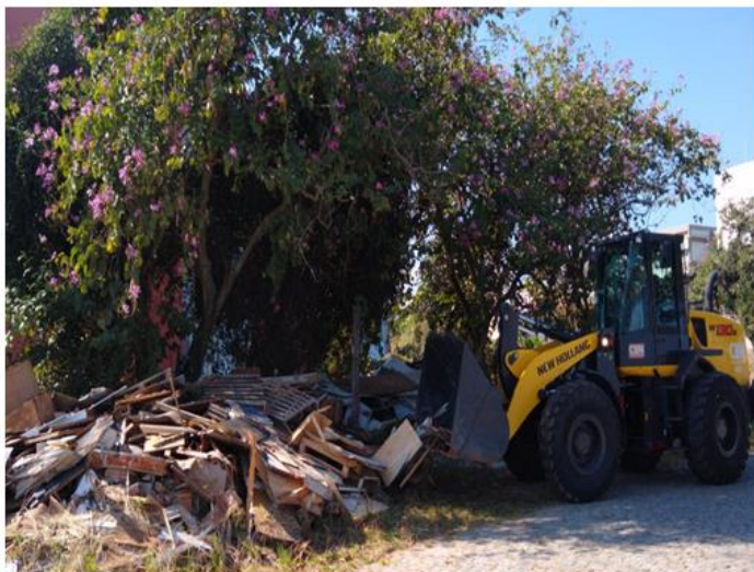
Dia 04/08/2020 - Retirada de madeiras enfrente a obra do IACS na orla do Campus Gragoatá.
