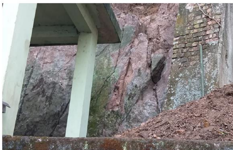
Dia 05/08/2020 - Maciço rochoso durante a obra da encosta na Reitoria.
