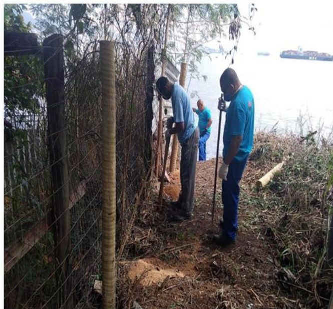
Dia 24/08/2020 - Remontagem do telamento da orla na lateral da Moradia Estudantil no Campus Gragoatá.
