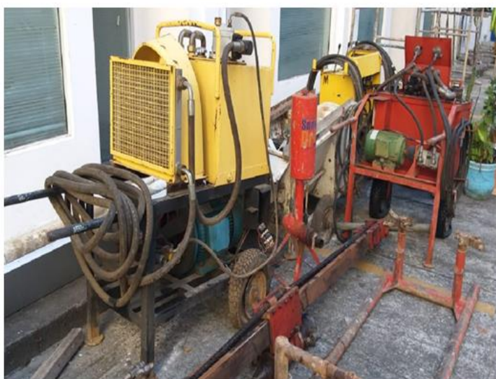
Dia 05/08/2020 - Equipamentos de perfuração de estacas raiz e de compressão para obra da encosta na Reitoria.
