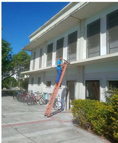
Dia 04/08/2020 - Instalação de luminária solar na Moradia Estudantil no Campus Gragoatá.
