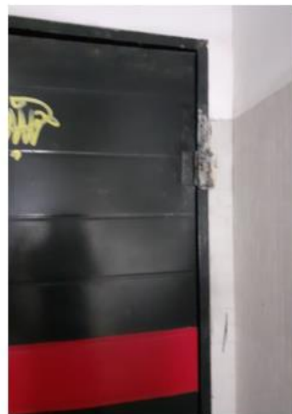
Dia 25/02/2022 - Solda e instalação de 06(seis) dobradiças em 02(duas) portas corta-fogo do Bloco B no Campus Gragoatá.
