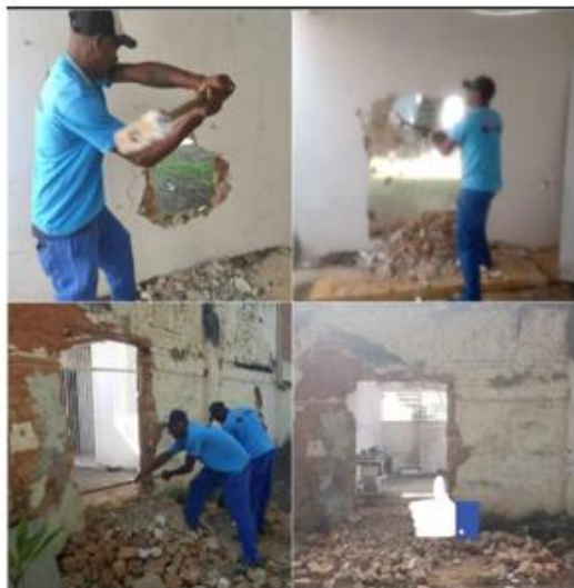
Dia 07/02/2022 - Demolição de parede do SPA visando abertura de passagem para novo espaço em Campos dos Goytacazes.
