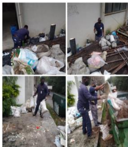
Dia 18/02/2022 - Remoção de entulhos para caçamba localizada no Campus Praia Vermelha.
