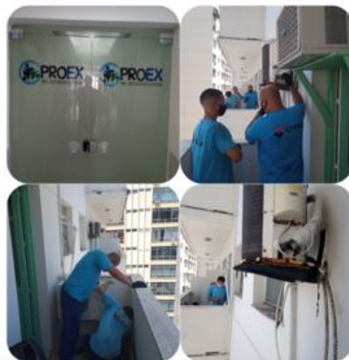
Dia 27/01/2022 - Desinstalação de 02 (dois) aparelhos de ar-condicionado, tipo Split, no 6º andar, Proex na Reitoria.
