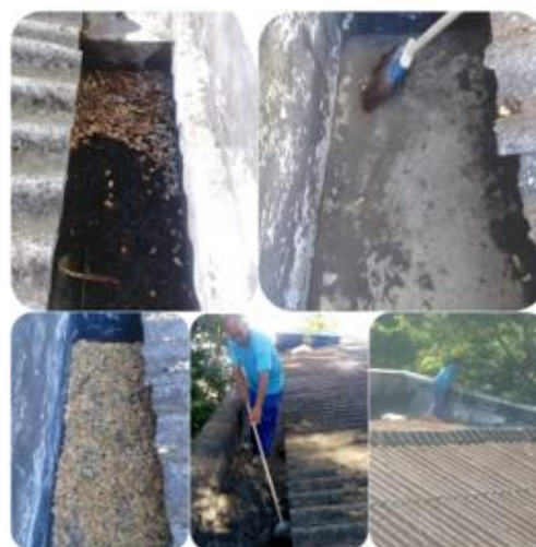
Dia 10/01/2022 - Limpeza e verificação de vazamento nas Calhas e Telhado da Biblioteca Central no Campus Valonguinho.
