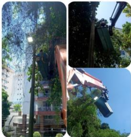
Dia 24/01/2022 - Troca de luminárias comuns para sistema LED nos postes de rua ao redor do Campus Praia Vermelha.
