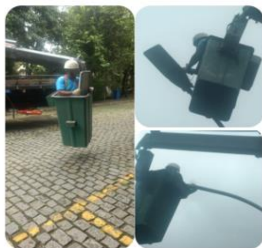
Dia 19/01/2022 - Troca e instalação de luminárias nos postes da Praia Vermelha e Valonguinho com a ajuda do Caminhão Munck.
