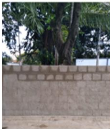
Dia 31/01/2022 - Construção de parte do muro principal do Mequinho.
