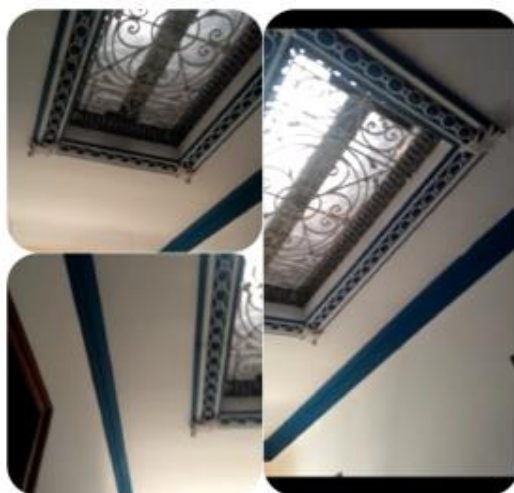
Dia 19/01/2022 - Pintura no teto do Casarão em Nova Friburgo.
