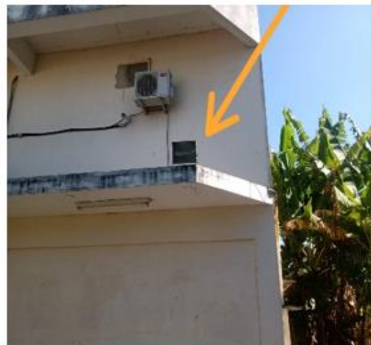
Dia 18/01/2022 - Troca da lâmpada do refletor fixado na marquise do Bloco G em Campos dos Goytacazes.
