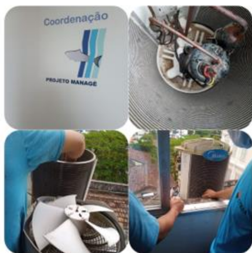
Dia 06/01/2022 - Inspeção técnica de aparelho de ar-condicionado, tipo Split, na sala da Coordenação da Faculdade de Direito II.
