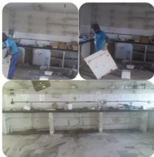
Dia 14/01/2022 - Demolição e retirada de materiais no prédio da Antiga Biologia no Campus Valonguinho.
