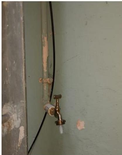
Dia 25/06/2020 - Vazamento d'água por quebra de uma torneira.
