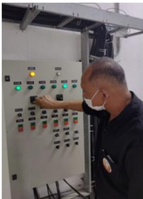
Dia 23/06/2022 - Reparo na parte elétrica do prédio da COSEAC no Campus Gragoatá.
