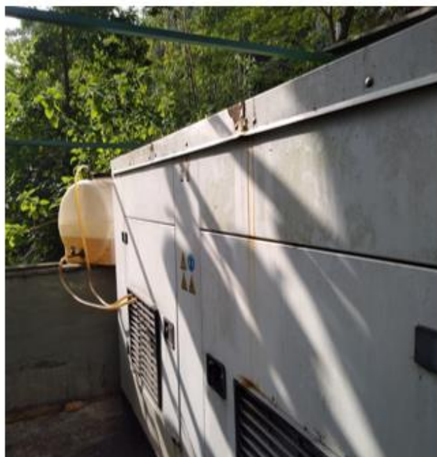
Dia 25/06/2022 - Limpeza do tanque de diesel do gerador do prédio do Instituto Biomédico no Campus Valonguinho.
