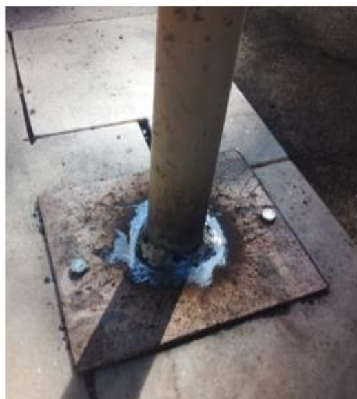
Dia 28/06/2022 - Aplicação de solda no pé de corrimão na entrada do prédio da Morfologia no Campus Valonguinho.
