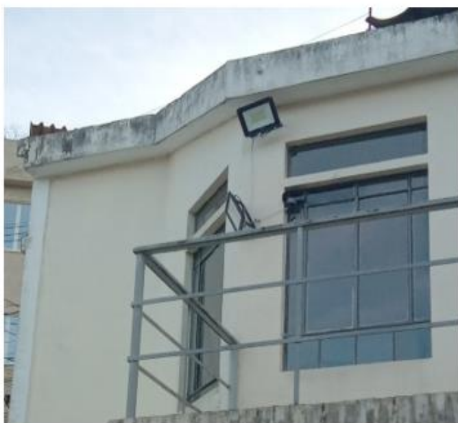
Dia 23/06/2022 - Instalações de refletores na entrada principal da unidade de Nova Friburgo.
