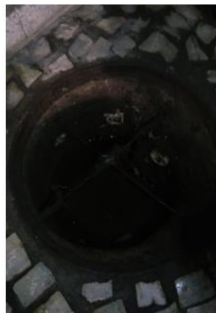
Dia 09/06/2022 - Limpeza de esgoto na Reitoria.
