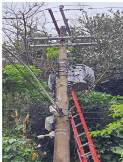
Dia 06/06/2022 - Instalação de transformador para a casa de sustentabilidade na Praia Vermelha.
