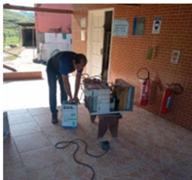
Dia 02/06/2022 – Realizado 14 (quatorze) manutenções preventivas de aparelhos de ar condicionado em Cachoeiras de Macacu.
