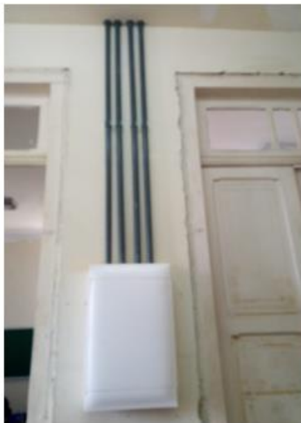
Dia 20/06/2022 - Instalação de tubos para posterior passagem de fios em quadro elétrico no Bloco B em Campos dos Goytacazes.
