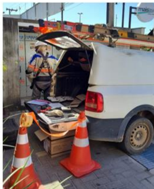
Dia 29/06/2022 – Instalação de medidores de energia elétrica em Rio das Ostras.
