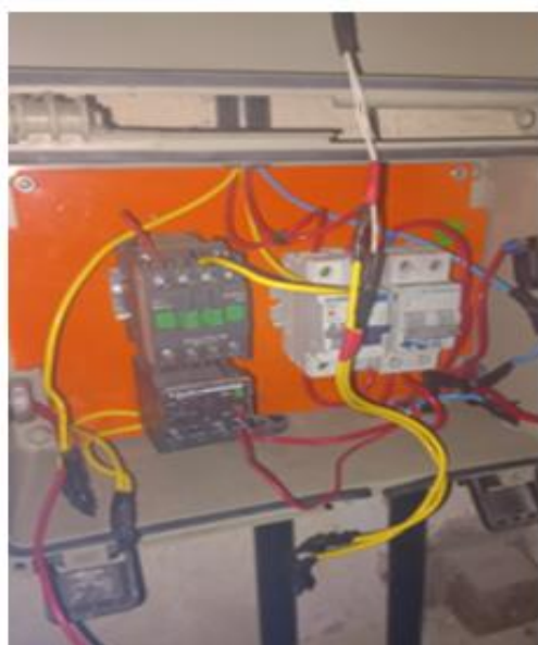
Dia 02/06/2022 - Troca de contactor e reparo no comando de bomba no 5º andar do Instituto de Química no Campus Valonguinho.
