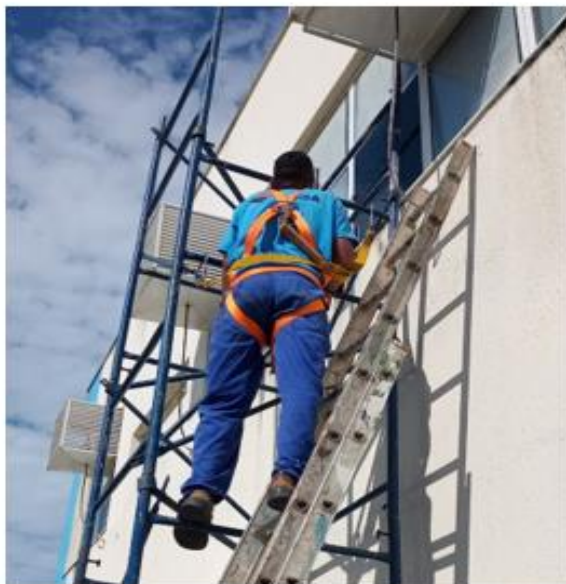
Dia 09/06/2022 – Realizada a instalação do suporte para aparelho de ar-condicionado na sala 8 no SPA em Rio das Ostras.
