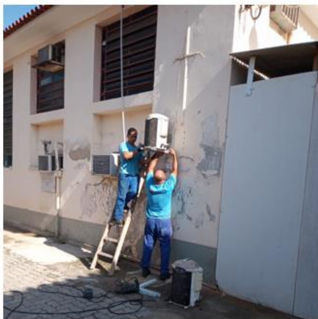
Dia 23/06/2022 - Instalação de 03 aparelhos de ar-condicionado, tipo split, na Faculdade de Farmácia.
