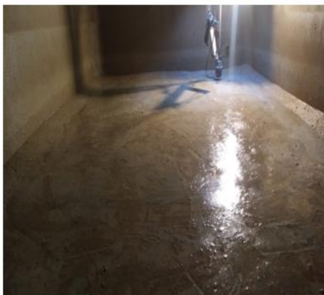
Dia 08/06/2022 – Limpeza em reservatório d'água no Bloco P do Campus Gragoatá.
