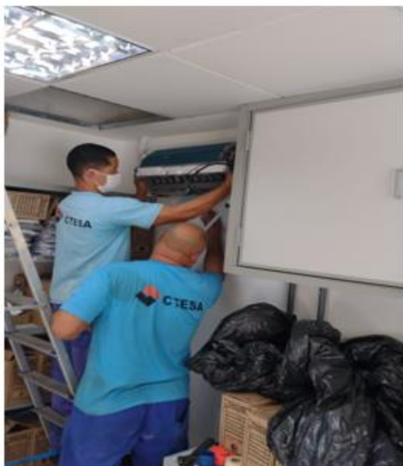
Dia 06/06/2022 - Instalação de 01 (um) aparelho de ar-condicionado, tipo split, na Divisão de Benefícios (DBE/CRL) no 4º andar da Reitoria.
