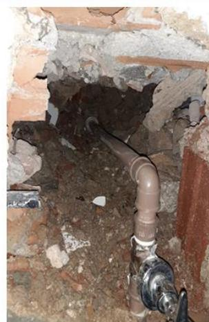
Dia 27/05/2020 – Foi aberta a alvenaria, e substituídas as conexões existentes, que se encontravam estufadas, e sem selantes para solução do vazamento no NAL do Campus Valonguinho.
