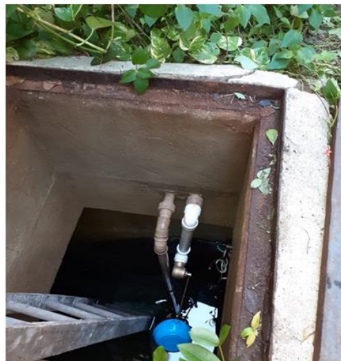
Dia 31/03/2020 – Instalação de boia da Cisterna do bloco H no Campus Praia Vermelha.
