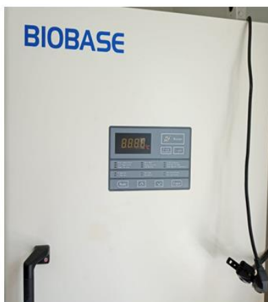
Dia 31/03/2020 – Instalação de instalação de tomada para equipamento do DST no Campus Valanguinho.
