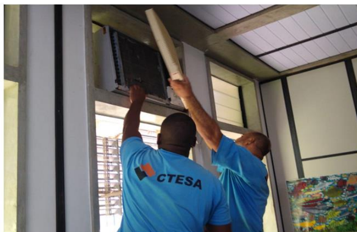
Dia 12/03/2020 – Retirada de aparelho de Ar-Condicionado da sala 425 no Bloco D do Campus Gragoatá.
