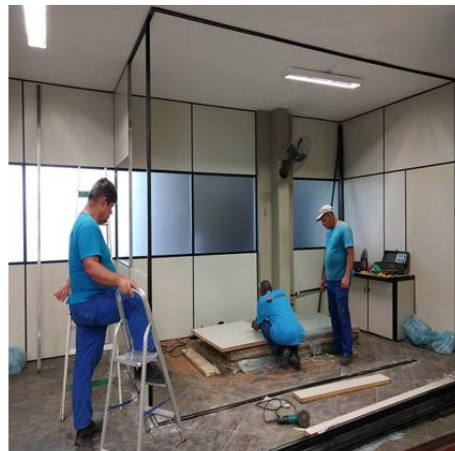
Dia 04/03/2020 – Montagens de divisórias no SDC no Campus Gragoatá.
