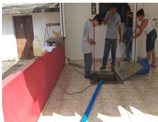
Dia 13/03/2020 – Serviço de limpeza dos reservatórios d'água na Faculdade de Farmácia.
