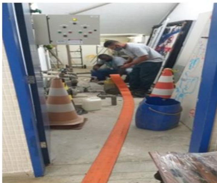
Dia 23/10/2020 - Serviço de limpeza dos reservatórios d'água do bloco A do Campus Gragoatá.
