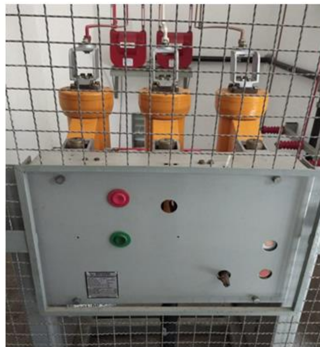
Dia 29/10/2020 - Manutenção preventiva da subestação do Instituto de Química no Campus Valonguinho.
