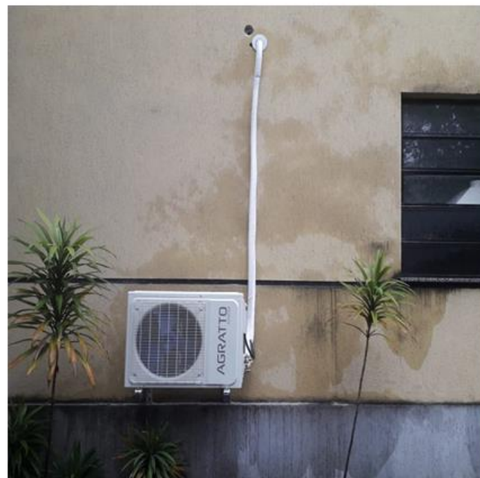
Dia 30/10/2020 - Instalação aparelhos de Ar-condicionado Split na HUVET na Faculdade de Veterinária.
