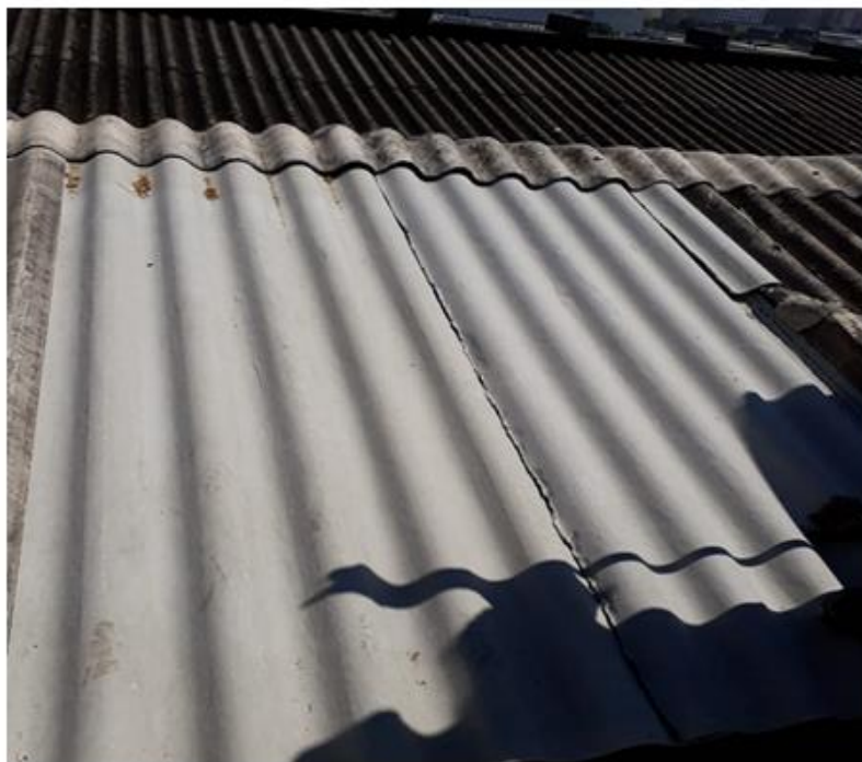
Dia 28/10/2020 - Substituição das telhas quebradas na Biblioteca Central do Valonguinho.
