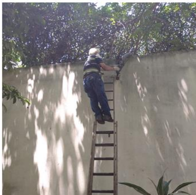
Dia 27/10/2020 - Troca dos conectores do ramal alimentador do Mazzini Bueno no Campus Valonguinho.
