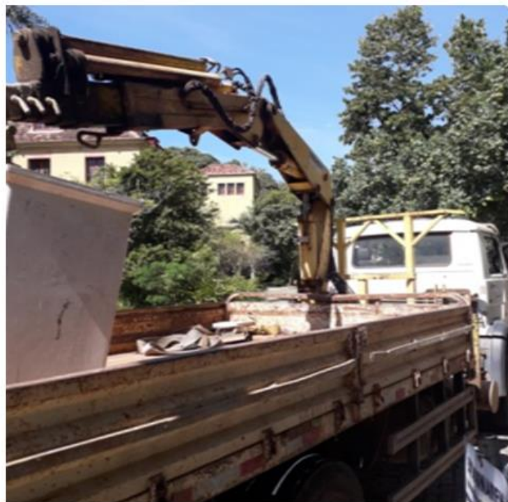
Dia 23/10/2020 – Troca das Fotocélulas e luminárias, com ajuda de Caminhão Munck, nos postes da área externa do Campus Praia Vermelha.
