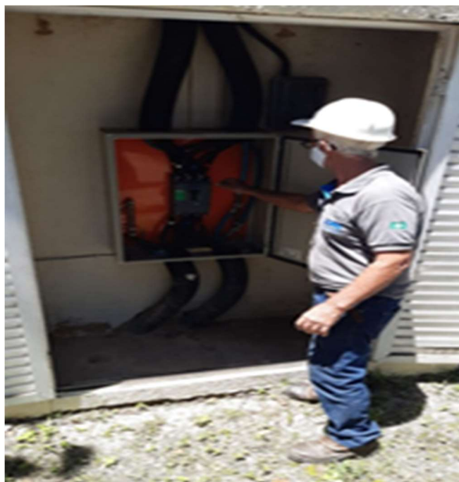
O servidor Ademar Resende na manutenção preventiva da Subestação do PUCG Instituto de Ciências da Sociedade e Desenvolvimento Regional – Campos/RJ
